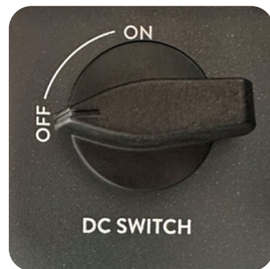
Slika 18: Deaktivacija fotonaponskog napajanja istosmjernom strujom_1.1
