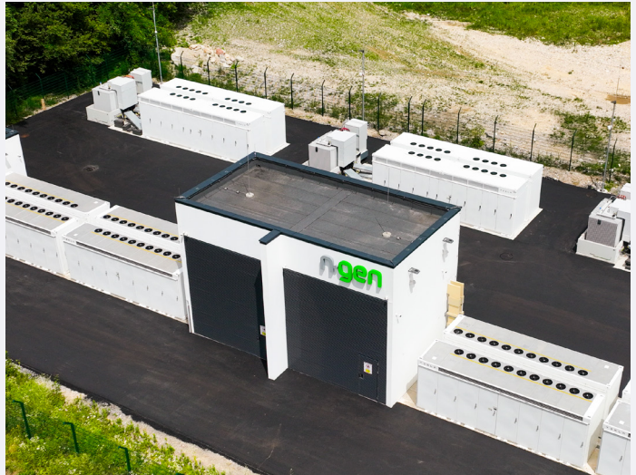
14 × MEGAPACK XL, NETZSTABILITÄT DURCH REGLERESERVE
